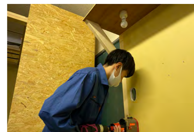
▲電気工事实習の様子
