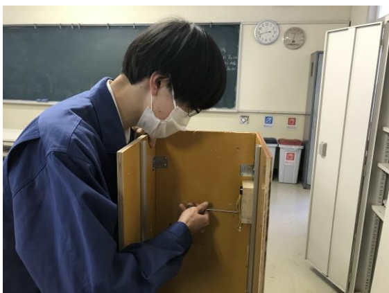
図4 リミットスイッチの固定作業
