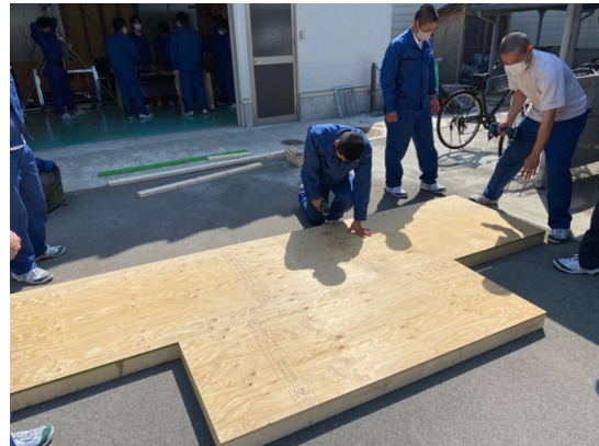
写真1 フレームの組み立て
