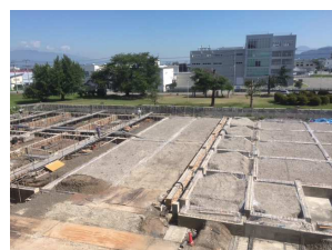
△工事の様子(7月27日現在)
